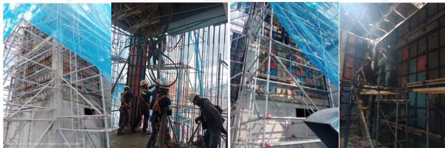
Contrato 925-2023 Reforzamiento Estructural
