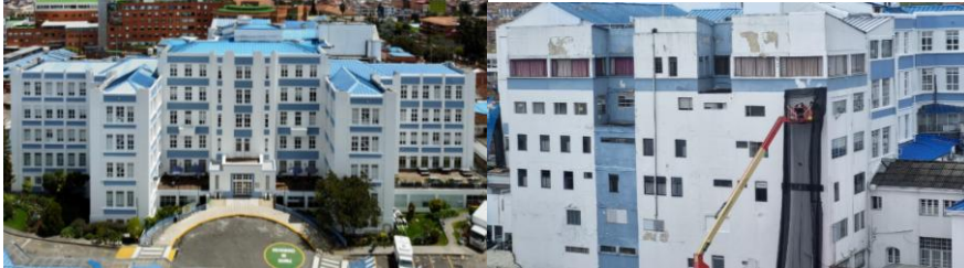
Contrato 416-2024 Pintura de Fachadas
